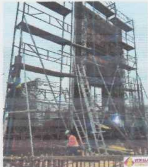
Montaj armatura rigida metalica si confectii Catedrala Mantuirii Neamului – Bucuresti
