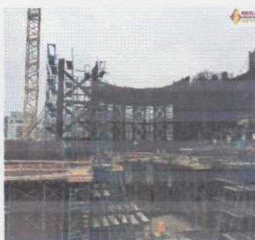
Montaj armatura rigida metalica si confectii Catedrala Mantuirii Neamului – Bucuresti
